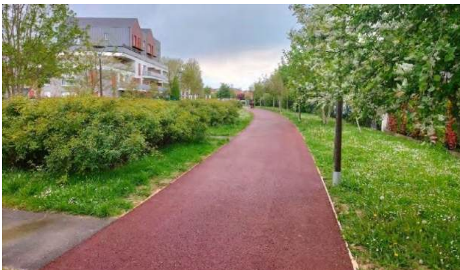
Ex. 3 : Enrobé coloré en rouge (avec un liant d'origine végétale ou bitumineux ?) - récent) - Voie verte à Lieusaint (77)
