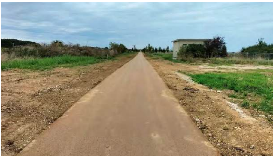
Végécol® (Colas) enrobé avec un liant d'origine végétale ; 2024 - Voie verte de la Base 217 au Plessis-Pâté (91)
