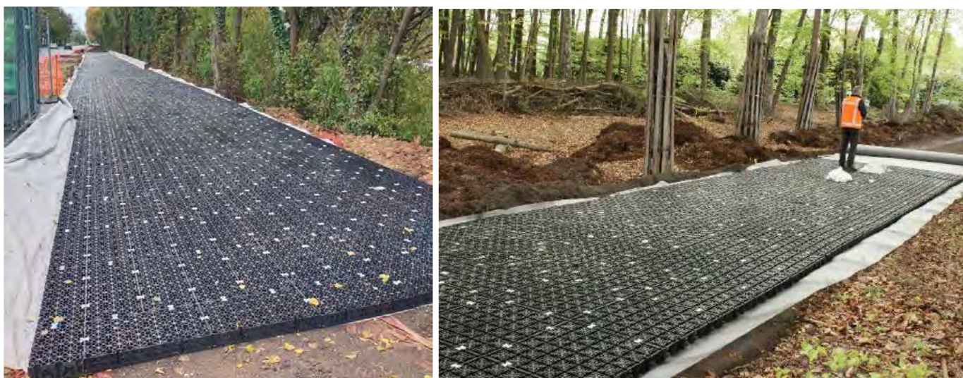
Permavoid® : A gauche : assise de la piste cyclable de la D445 le long d'un alignement de peupliers à Fleury-Mérogis en 2023. A droite : construction de l'assise d'une piste cyclable dans un espace boisé à Epe (Pays-Bas) en 2018
