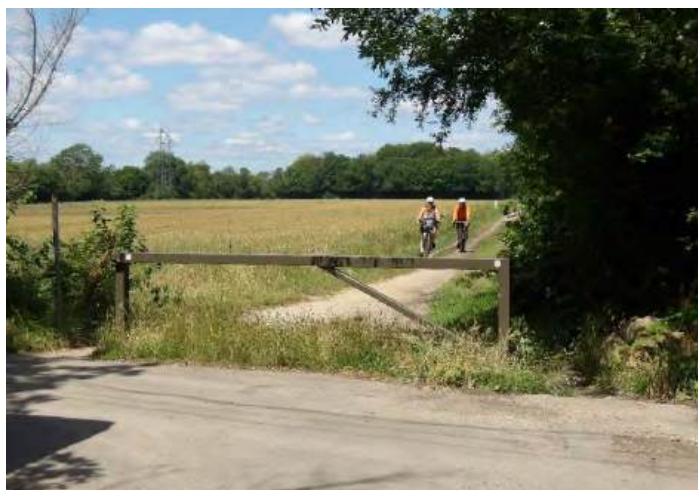
Barrières inefficaces contre les deux-roues motorisées et gênantes pour les PMR à Draveil et à Soisy-sur-Seine
