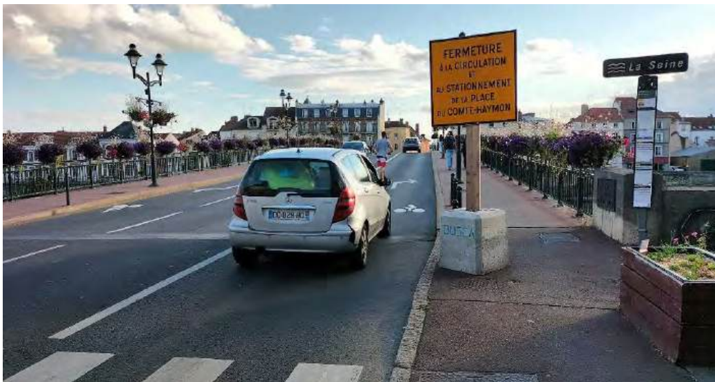
Pont Patton à Corbeil-Essonnes
