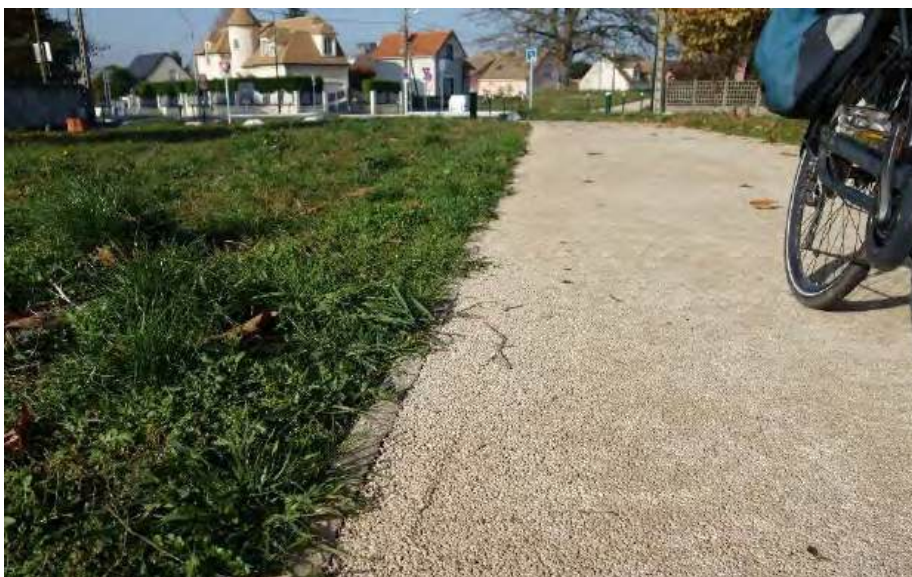
Exemple d'enrobé drainant (Urbatli®) à très forte capacité d'infiltration de l'eau, sur la voie verte de l'aqueduc de la Vanne et du Loing à Savigny-sur-Orge.
