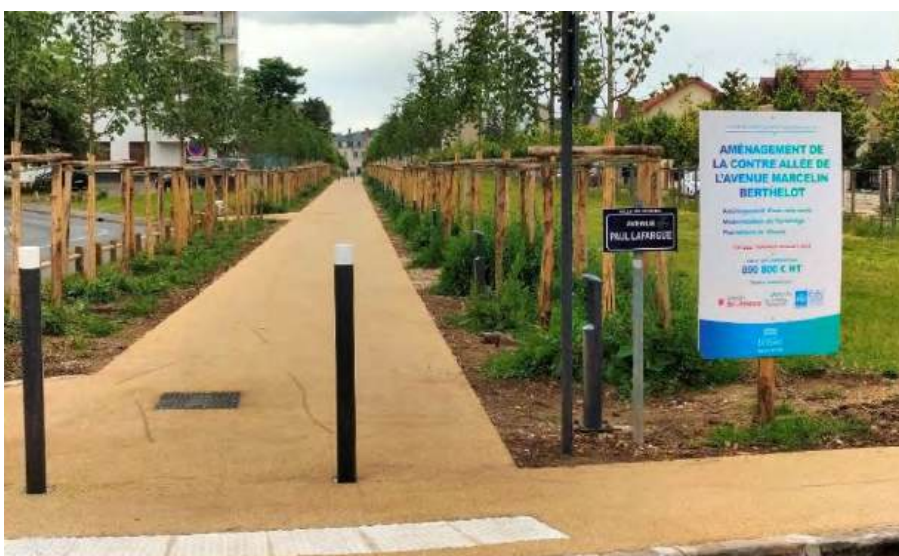
Hydrovia® soft 0-6 beige (Vinci) : Enrobé drainant, liant bitumineux couleur beige clair – 2024 Avenue Berthelot à Draveil
