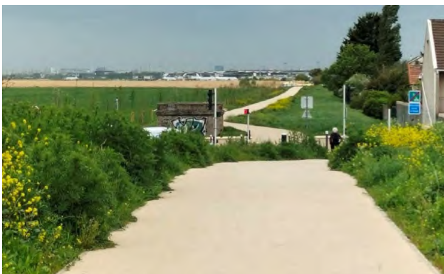
Ex. 4 : Urbalith® (Colas) : Enrobé drainant, clair, à liant organo-minéral Aqualib (label Ineris) – 2023 - Voie verte de l'aqueduc de la Vanne à Paray Vieille poste (91)
