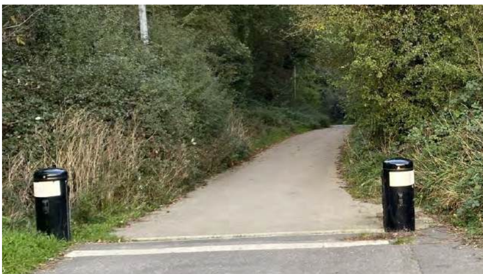
Bioklair® (Eiffage) Enrobé avec un liant issu des sous-produits de papeteries de pins – Récent. Voie verte du Chemin du trou rouge à Vauhalla (91). Ce liant d'origine végétale donne une teinte caramel dans un premier temps, puis il se décolore et devient translucide et laisse apparaître la teinte du granulat utilisé.
