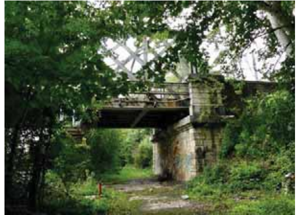
15. Passage sous pont SNCF (photo E. Marchandise)
