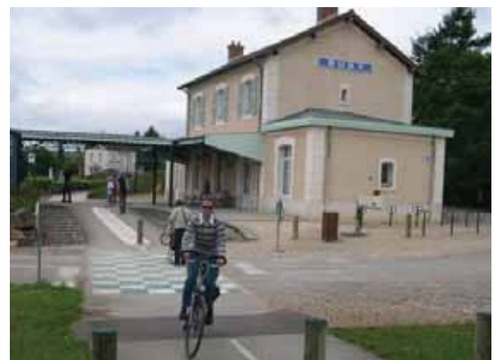
Gare de Buxy en Saône-et-Loire, transformée en « Maison du Vélo »
