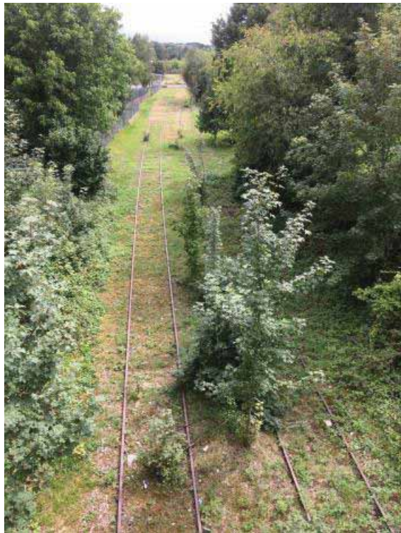
12. Emprise ferroviaire à Mussy-sur-Seine (photo Ch. Jacob)
