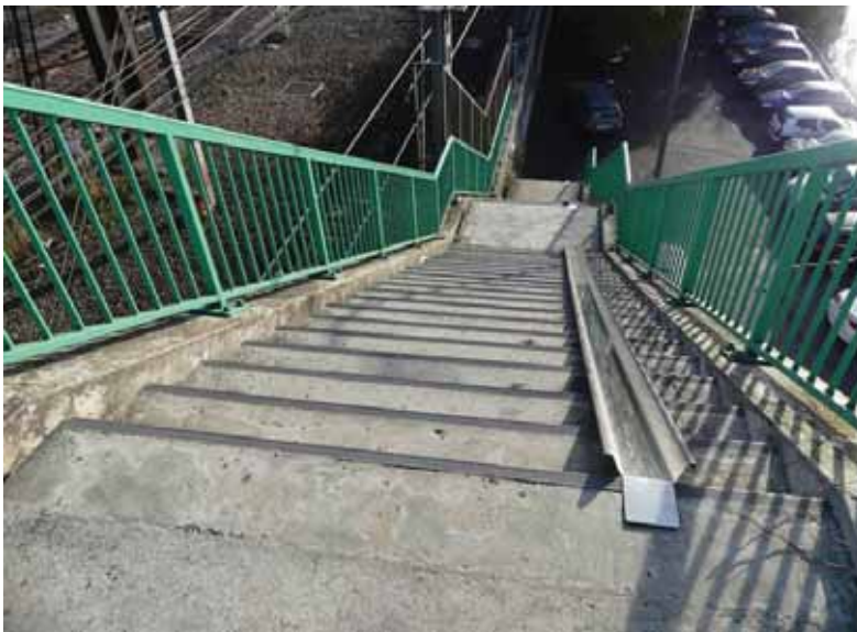
1. Pont de Villeneuve-le-Roi : principe de création d'une rampe pour descendre sur le quai (photo A. Duguet)
