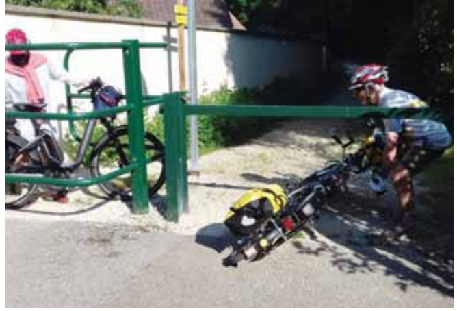
5. Chicane inadaptée côté Bar-sur-Seine (photo Ch. Jacob)
