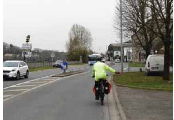
2. Amont du carrefour à sécuriser (photo E. Marchandise)
