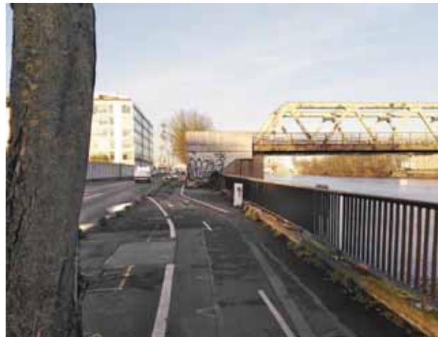
9. Quai Jules Guesde à Vitry. A droite, la « passerelle des gaz » (photo Ph. Ungerer)
