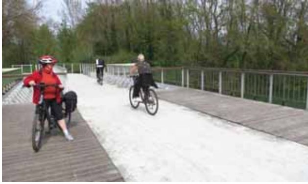
1. Nouveau pont-canal (photo Ch. Jacob)
