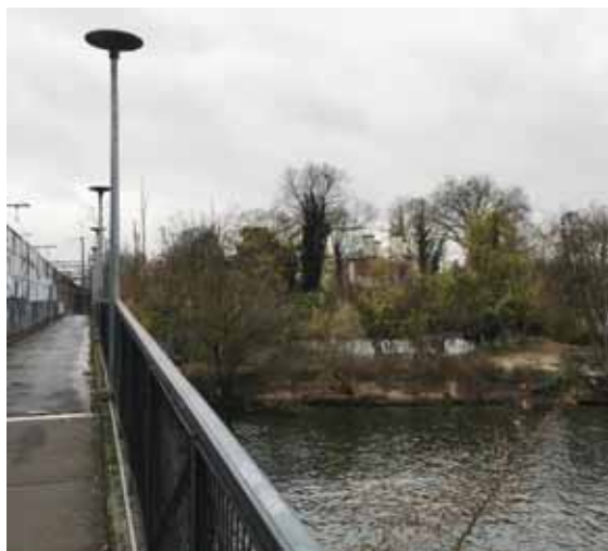
3. Passerelle de franchissement de l'Yerres, au droit de sa confluence avec la Seine (photo A. Duguet)
