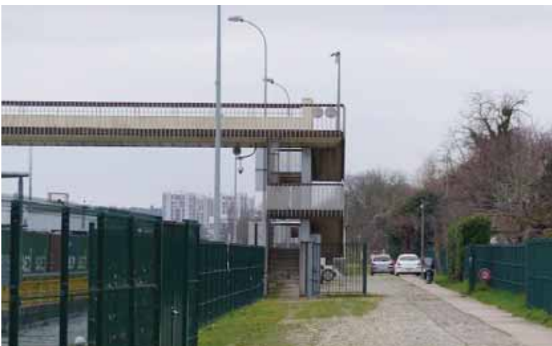
6. Ablon-sur-Seine : passerelle de l'écluse (photo A. Duguet)
