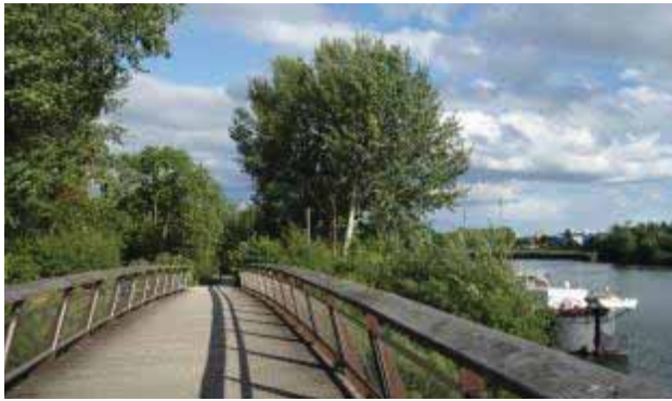
3. Draveil : Franchissement de l'accès au Port aux Dames (photo B. Carrouée)
