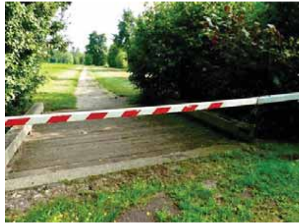
6. Deuxième passerelle sur le chemin de halage (photo Ch. Jacob)
