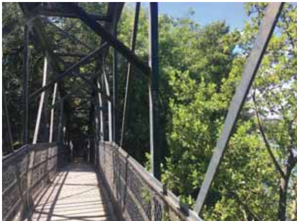
1. Draveil : franchissement de l'accès au bassin des Mousseaux (photo A. Duguet)
