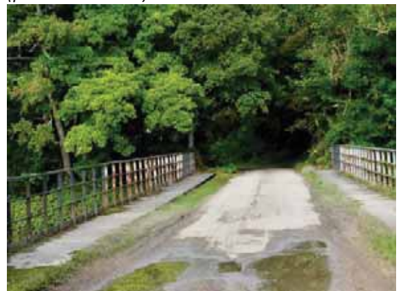
8. Troisième passerelle sur le chemin de halage (photo Ch. Jacob)
