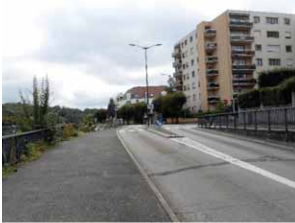
6. RD 326 à Melun : trottoir aménageable (photo M. Robert)
