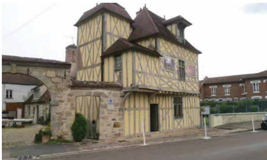
9. Ancienne route de Villenaux à Nogent (photo Ch. Jacob)
