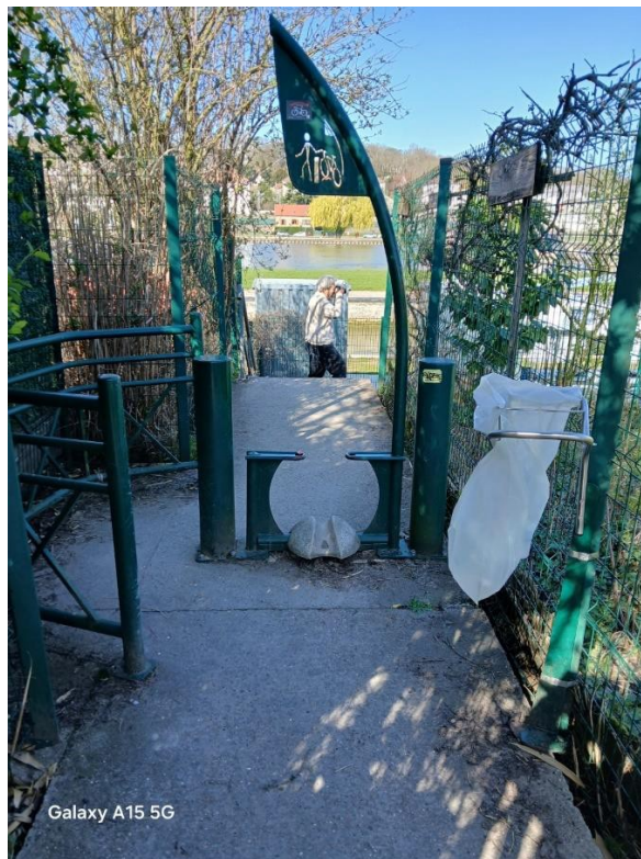
Portillon vers l'écluse d'Ablon pour forcer les cyclistes à descendre de leur vélo.
